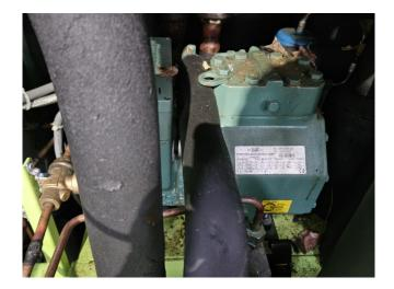
Typ 2KHC-05K-40S S.Nr. 1678912891 KUHLMASCHINENBAU GMBH Made in E.C. x Betr.stron ATA) AN ATZ 2.9 53 bar
